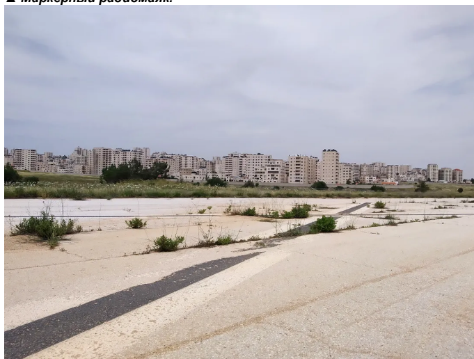
▲ Несмотря на местами пробивающуюся сквозь бетон растительность, полоса всё ещё пригодна для мотозабав.
