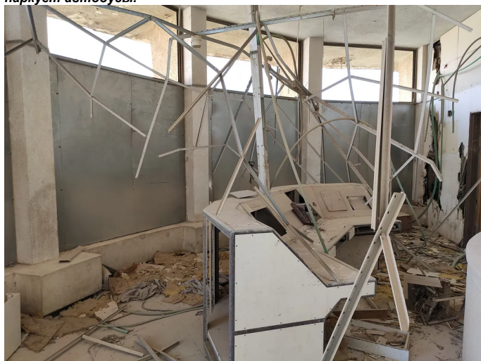
▲ Окна закрыты щитами изнутри и были затянуты противоснайперской сеткой снаружи.
